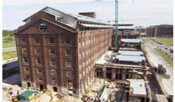
Docks en proceso de recuperación
