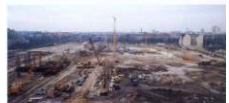
Faenas de construcción en Potsdamerplatz
